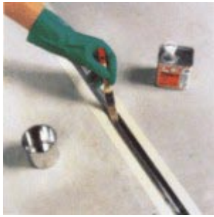
Očistené steny škár dosýta napentrovat' PCI Elastoprimerom. Po vyschnutí - min. 50 minút max. 2 hod....
